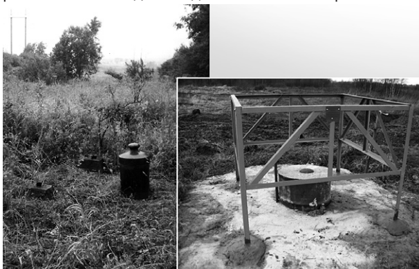
Рис. 1. Центр пункта ГГС (СК-95) «Кабози» до и после завершения реконструкции. Фото В.Б. Капцюга (2005 г.) и А.Ю. Виноградова (2009 г.).
